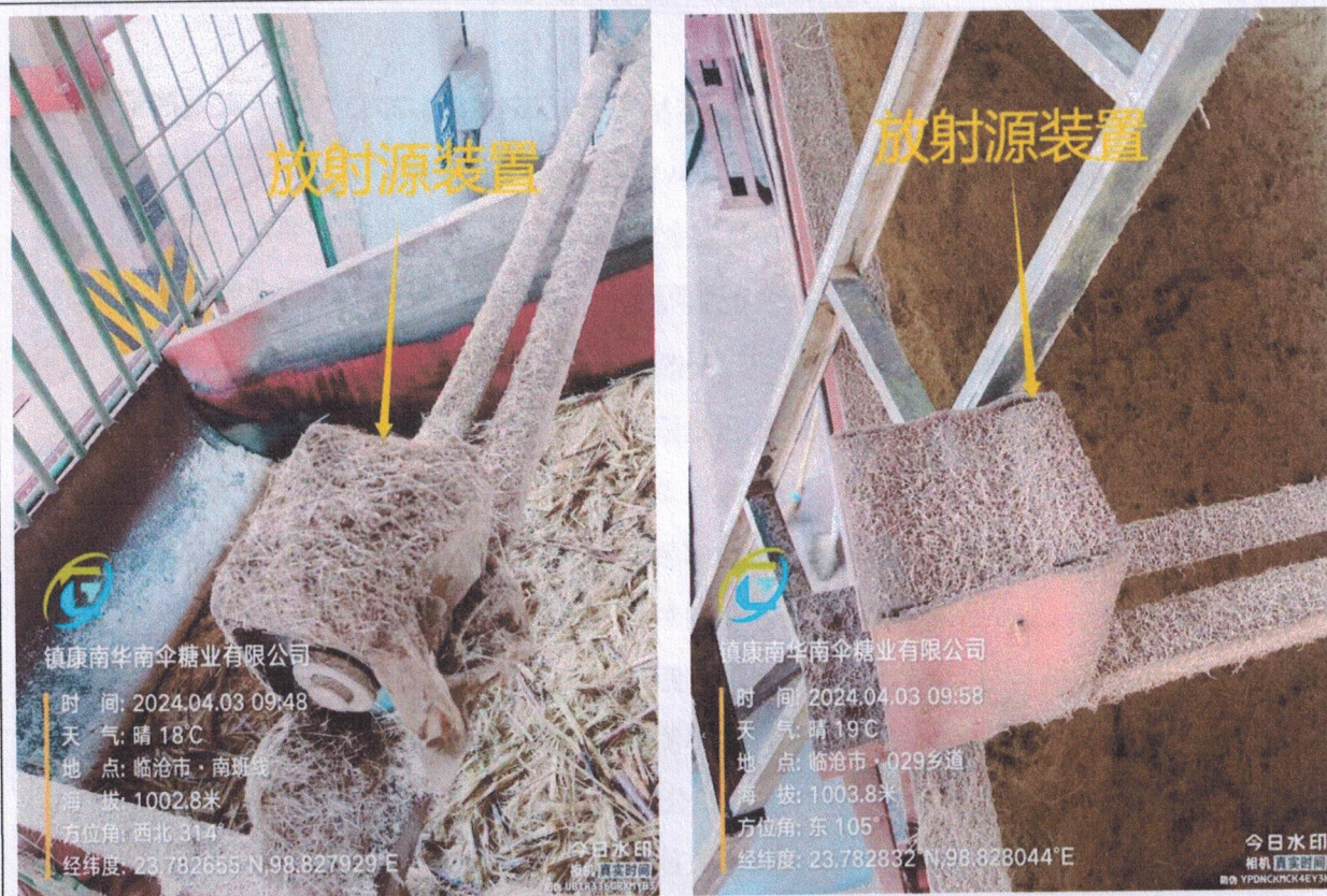
图3 镇康南华南伞糖业有限公司压榨车间在用放射源装置现场照片
