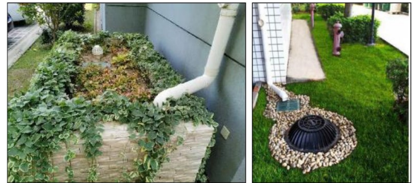
图 6-10 屋面雨水断接大样图及效果图
